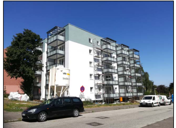
Block nach der Sanierung in der Raaschstraße
