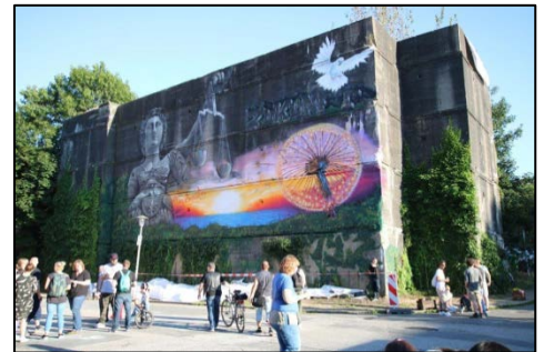
Bunker im Sandkrugquartier
